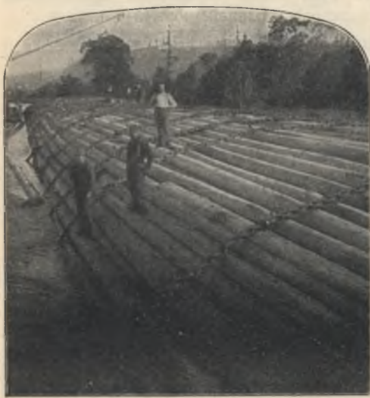
Сплавъ лѣса по рѣкѣ Колумбій. Огромный плотъ, связанный дѣвками; такой плотъ благополучно проходитъ черезъ пороги, и можетъ плавать даже по океану.
