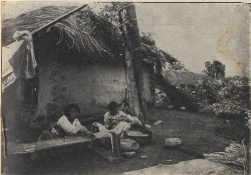
Корея. Тканье на ручномъ станкѣ. Хижина; возлѣ нея дымовая труба (отопленіе въ Корей устраивается такъ, что дымъ изъ печки идетъ подѣ глинянымъ поломъ и выходитъ черезъ трубу, поставленную возлѣ дома).
