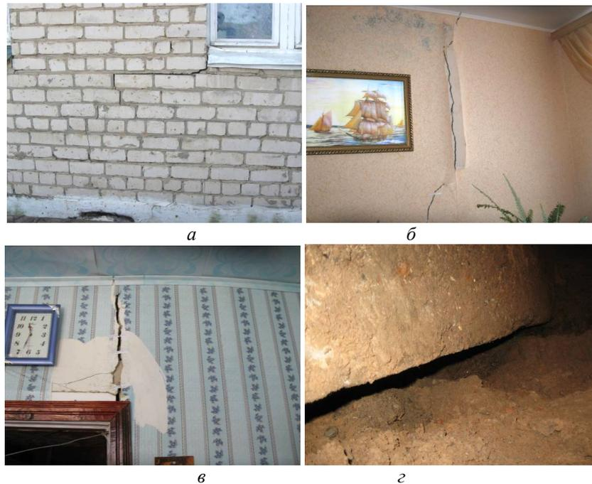
Рис. 5. Визуальные деформационные разрушения здания: *а* — вертикальные, горизонтальные и наклонные сквозные трещины в наружных кирпичных стенах здания с шириной раскрытия до 18 мм; *б, в* — деформации и просадки фундаментов здания в результате образования пустот (глубиной до 250 мм) в грунтовом основании под сборными железобетонными плитами ленточного фундамента; *г* — вертикальные и наклонные сквозные трещины во внутренних кирпичных стенах здания с шириной раскрытия до 16 мм
