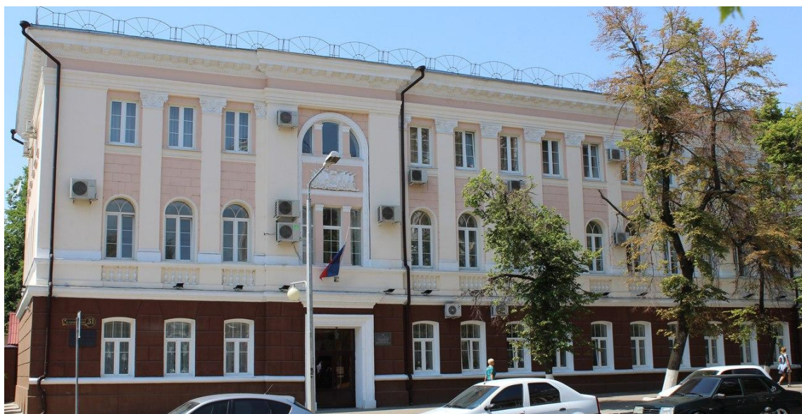
Рис. 2.10. Административное здание (современное здание Управления судебного департамента в Белгородской области). Объект ИКЗ «Старый Белгород» (фото автора)
