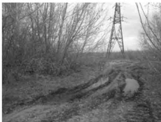
Рис. 6. Место, на котором геодезический пункт уничтожен
