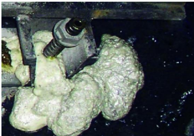
Рис. 1. Химическое анкерование пород кровли вспенивающимся составом
